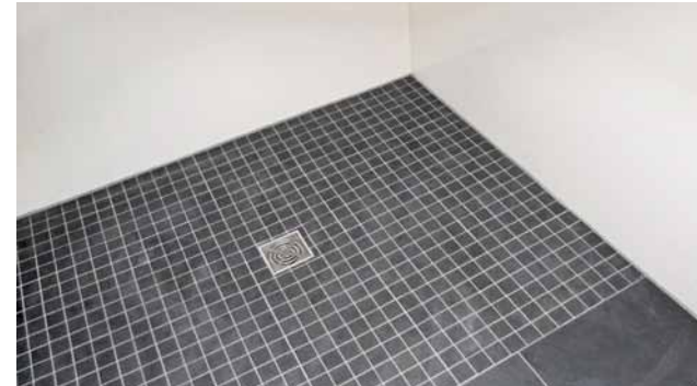
Kleinformatige Fliesen mit hohem Rutschgrad
