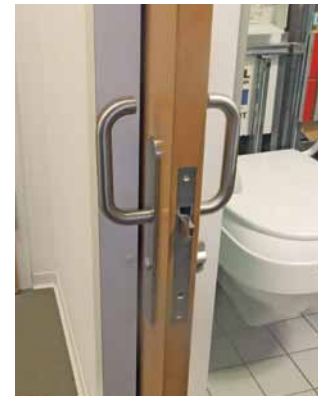
Greifgünstige Griffe, wie z. B. bogenförmige Griffe oder Bügel. Auf ausreichend lichte Durchgangsbreite achten, der Griff muss bei der Planung der Rohbauöffnung berücksichtigt werden.
