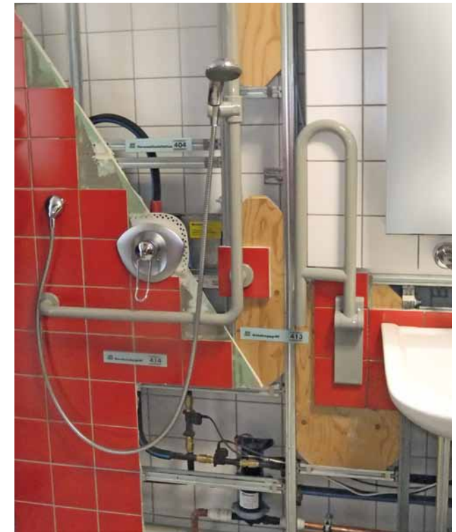
Installation der Sanitär-objekte
