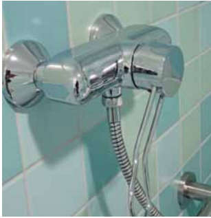
Einhebelmischer mit verlängertem Bedienhebel
